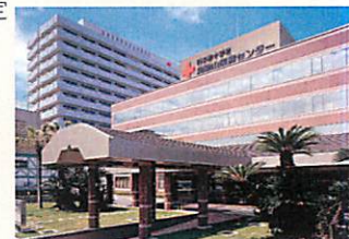
外装工事後の旧本館と南館(1995年)
